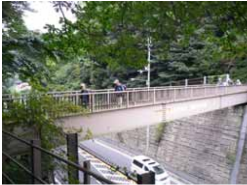
逢坂山歩道橋 13:29
