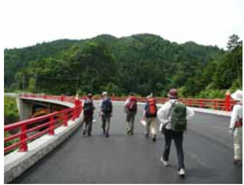
新しい室生路橋 10:11
