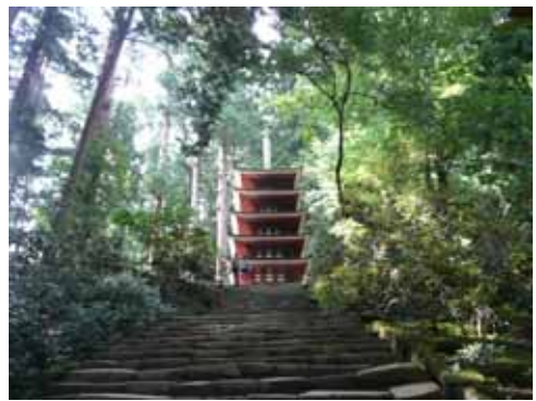
修復された 室生寺五重塔 15:19
